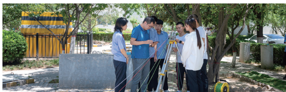
桥桩无损检测实训
