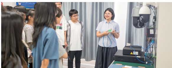
交通监控系统集成与维护实训
