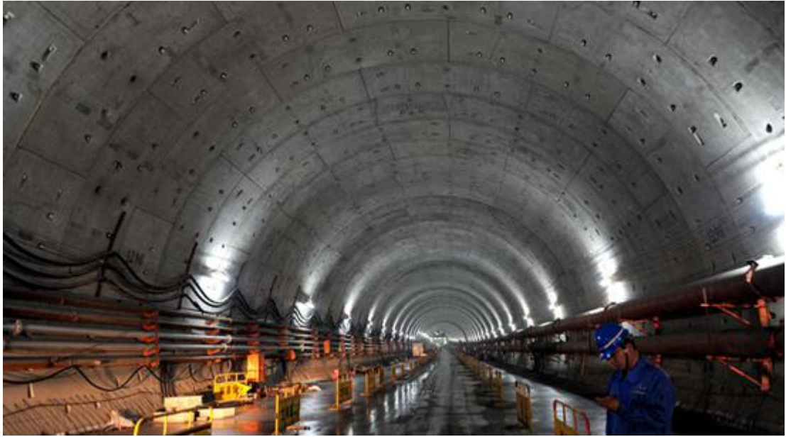
图 7.盾构法施工隧道内部
