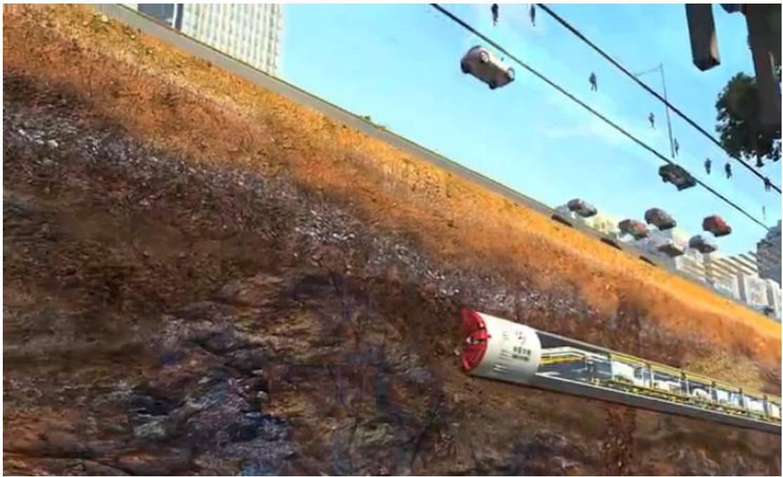
图 1.盾构法施工地下隧道
