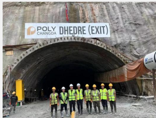
图 5-9 尼泊尔快速通道项目
